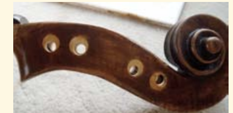
Abb. 3 Neu gebohrte Wirbellöcher
